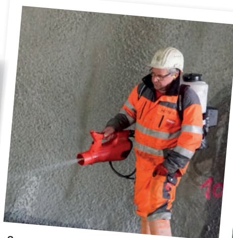
Construction de traitement de surface
